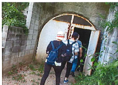
地下壕出入り口
